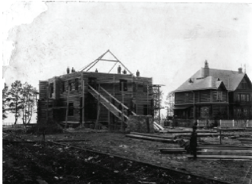
Строительство дач Л. Н. Бенуа и А. Э. Мейснера в деревне Бобыльской. 1890 г.
