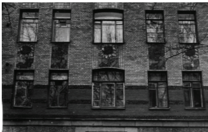
П. К. Ваулин. Майликовый декор фасада дома № 70 по 15-й линии Васильевского острова.
